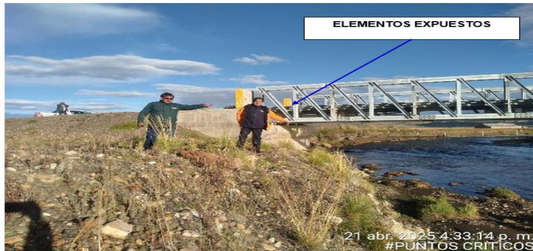
FIGURA N°01: FIGURA N°01: TRAMO CRÍTICO EN EL RÍO SANTA ROSA RIESGO DE SOCABACION DE DE LA RIBERAS DEL RIO, PONIENDO EN RIESGO EL PRINCIPAL PUENTE HUAMACUNCA, DISTRITO DE SANTA ROSA, PROVINCIA DE MELGAR - PUNO.
